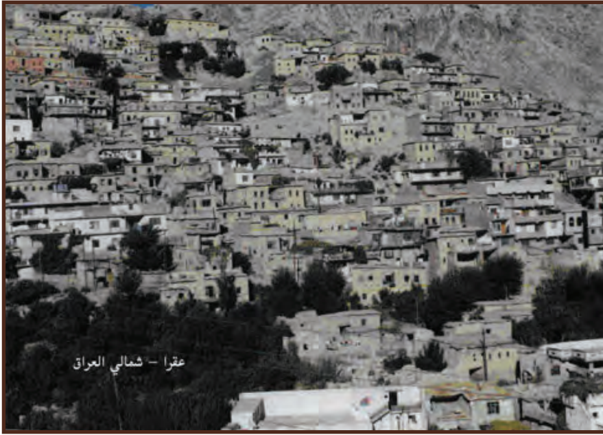
صورة (رقم ١) منظر عام للبيوت المتراكمة فوق بعضها البعض في قلعة عقرة
